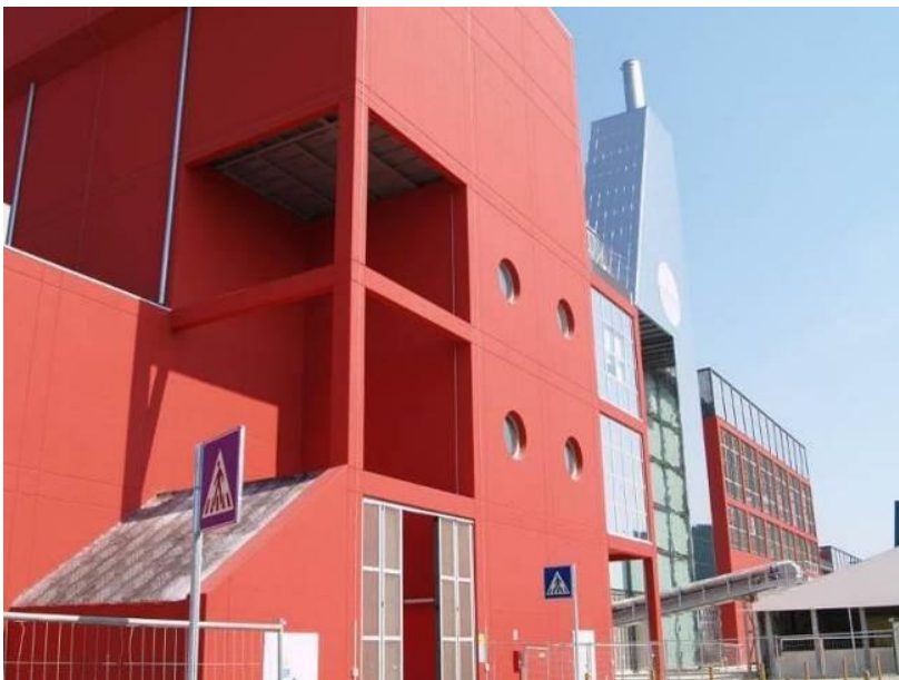
Figura 47 Facciata est con nastro di trasporto scorie
