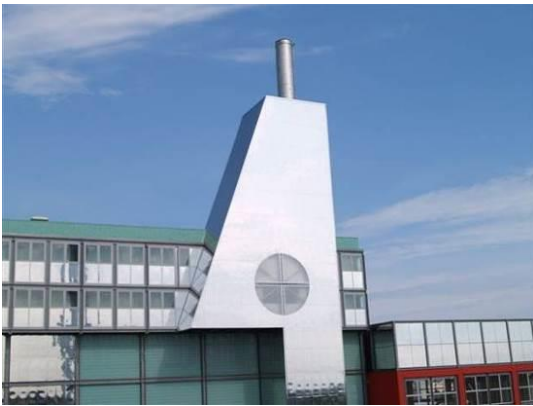
Figura 11 Particolare del camino dell'impianto
