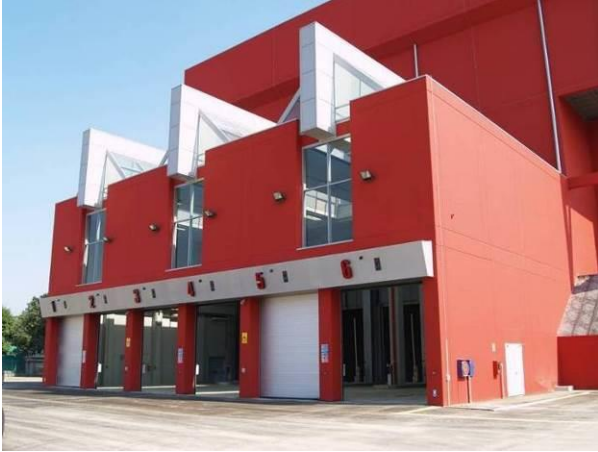
Figura 7 Particolare dell'avanfossa del termovalorizzatore
