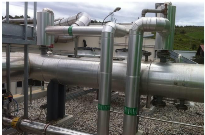
Figura 10 Sistema recupero calore dai fumi
