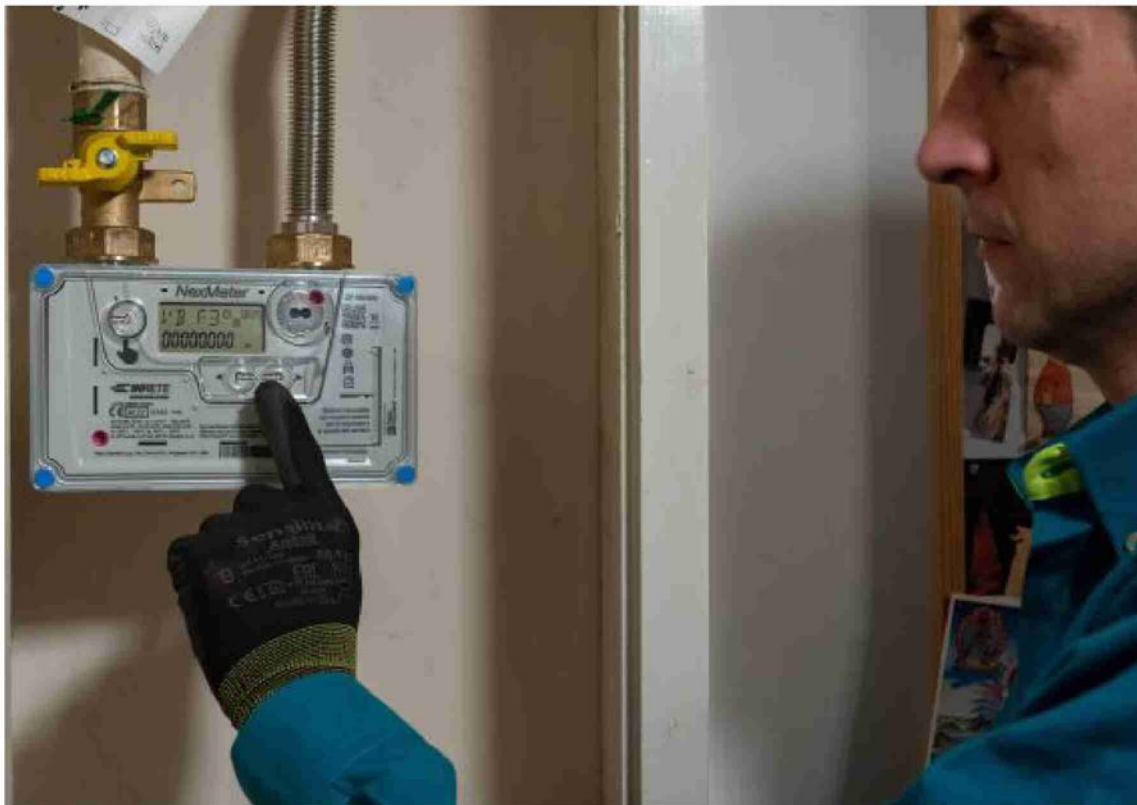
L'installazione di un contatore NexMeter
