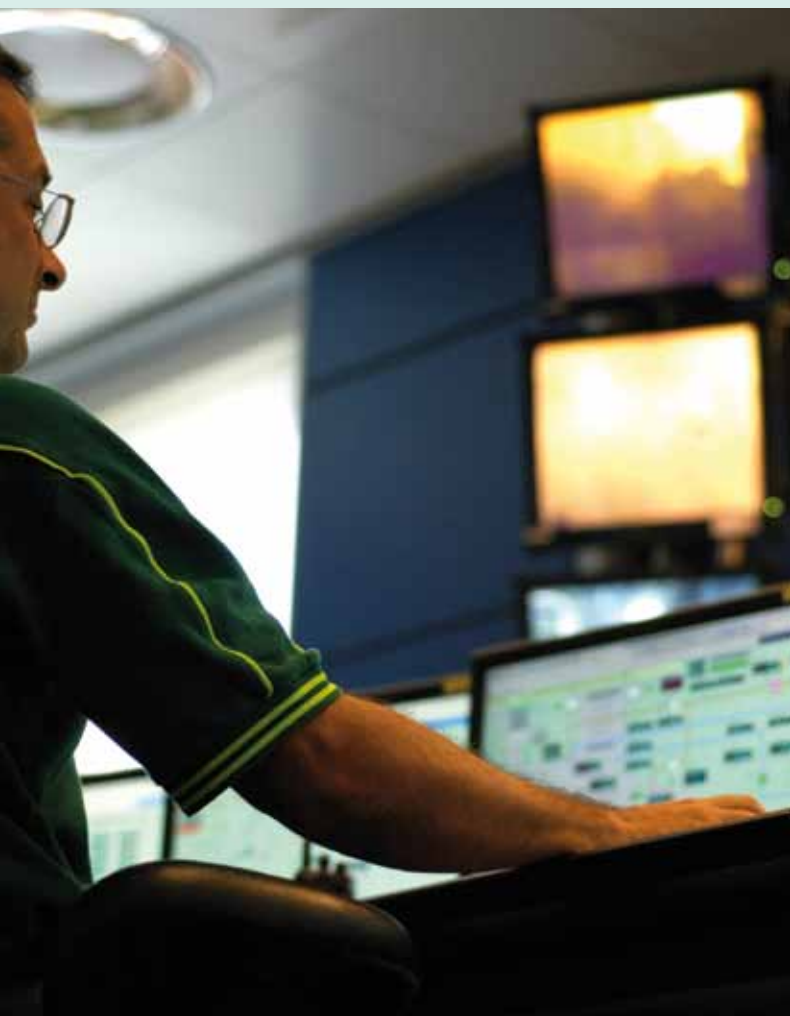
68 | Ferrara, sala di telecontrollo dell'impianto di termovalorizzazione.
