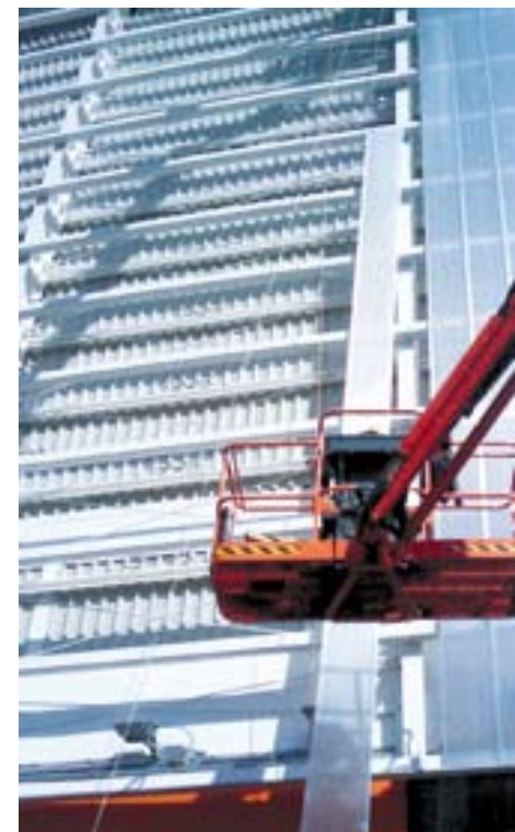
46 | Montaggio dei pannelli in polycarbonato. Si tratta di lastre in un pezzo unico, alte fino a 22 metri.
