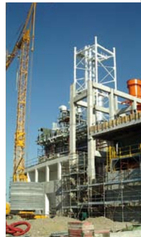
45 | Fase di costruzione intermedia del fabbricato principale e della torre.
