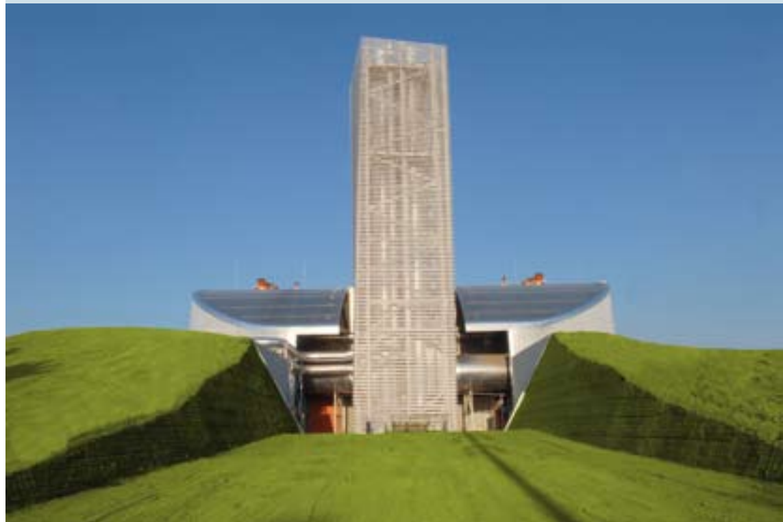
15 | Vista dell'impianto, lato est.
