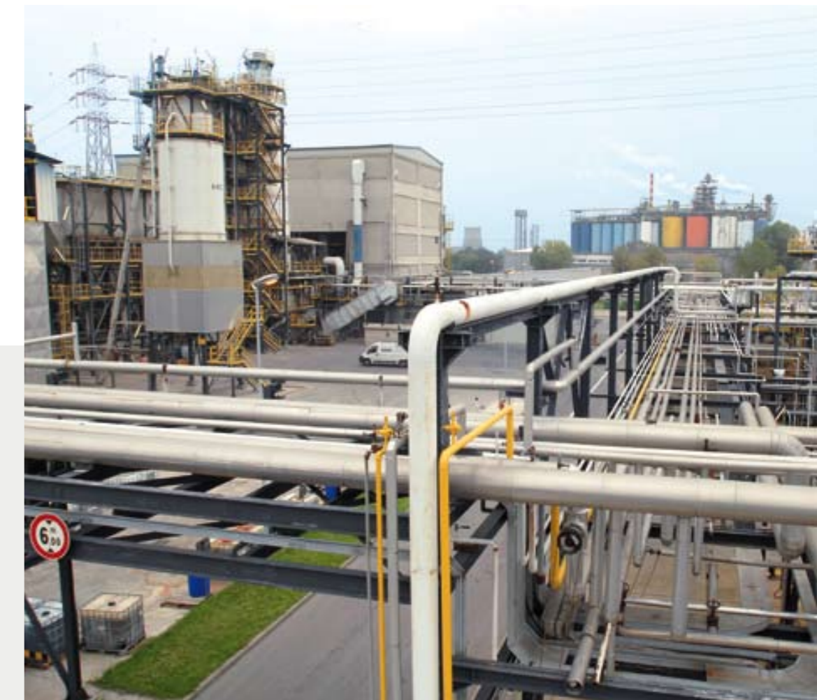
40 | Ravenna, l'impianto rifiuti speciali.
