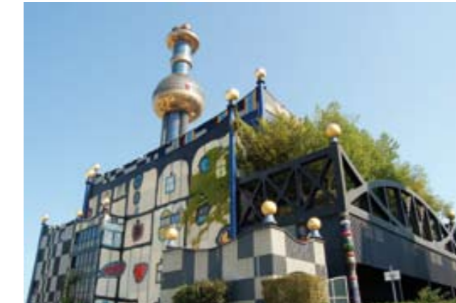
Impianto di Spittelau / Spittelau Plant
