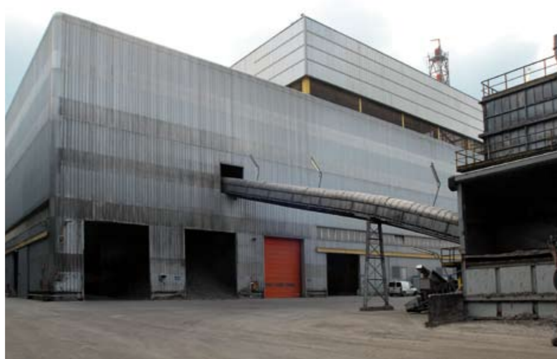
39 | Ravenna, l'impianto di termovalorizzazione.
