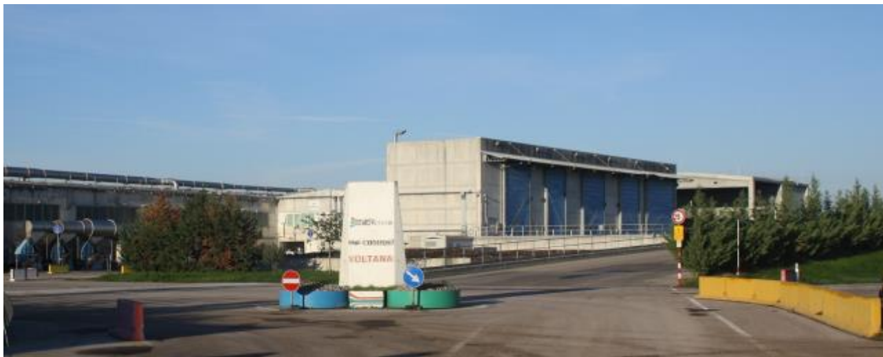
Figura 5 Vista dell'impianto di compostaggio
