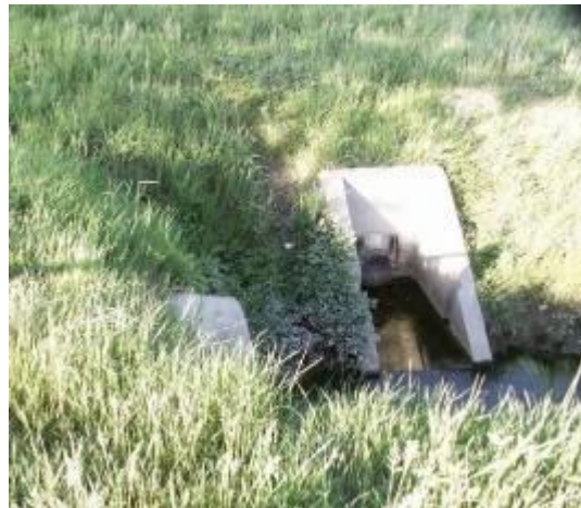
Figura 50 Punto di scarico S1/B
