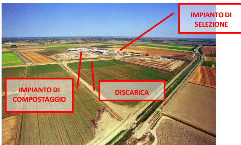
Figura 67 Foto del sito
