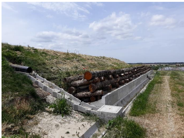
Figura 31 Particolare delle “pareti krainer”
