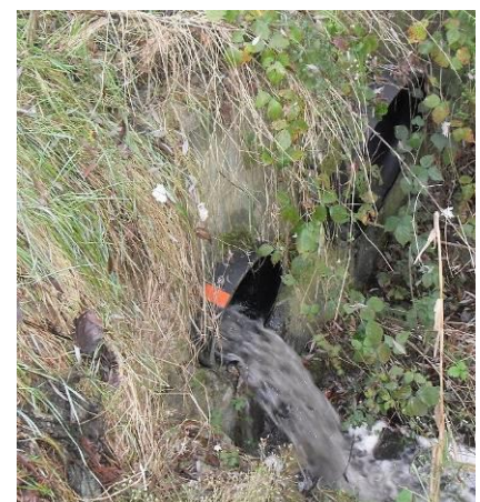
Figura 34 Scarico S2 e S3
