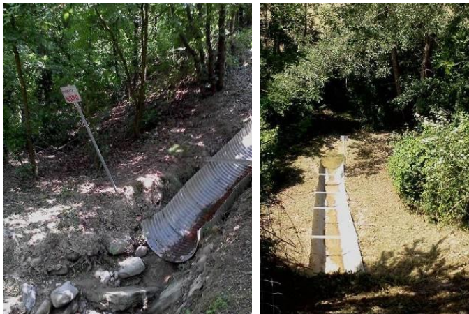
Figura 35 Particolari degli scarichi S2A e S2B
