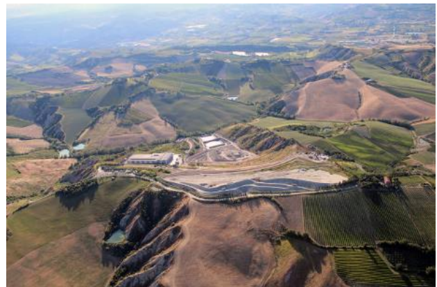
Figura 43 Foto del sito
