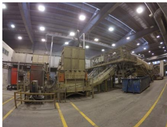
Figura 11 Impianto di tritovagliatura
