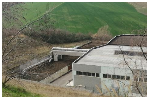
Figura 39 Biofiltro
