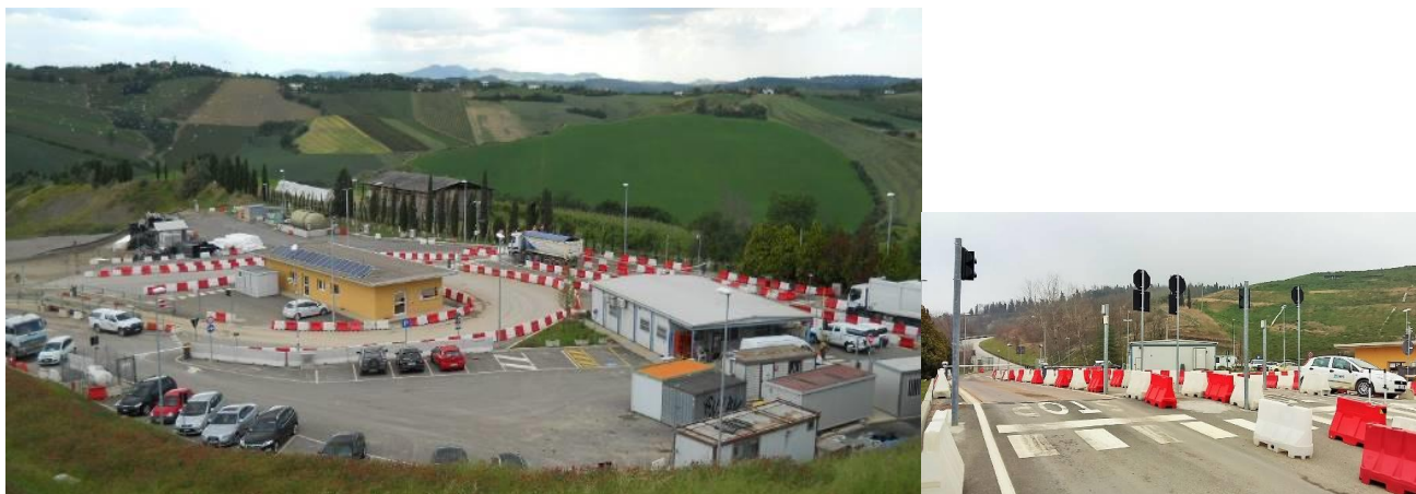
Figura 6 Veduta del Servizio di accettazione
