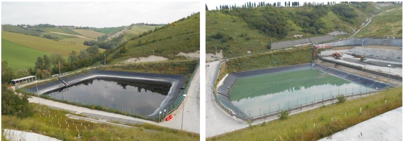
Figura 20 Vasche di stoccaggio percolato (V4 e V3)
