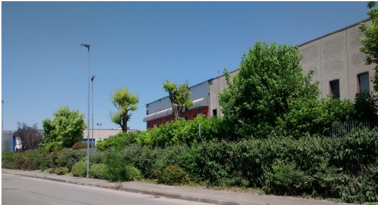
Figura 1 Vista esterna dell'Impianto
