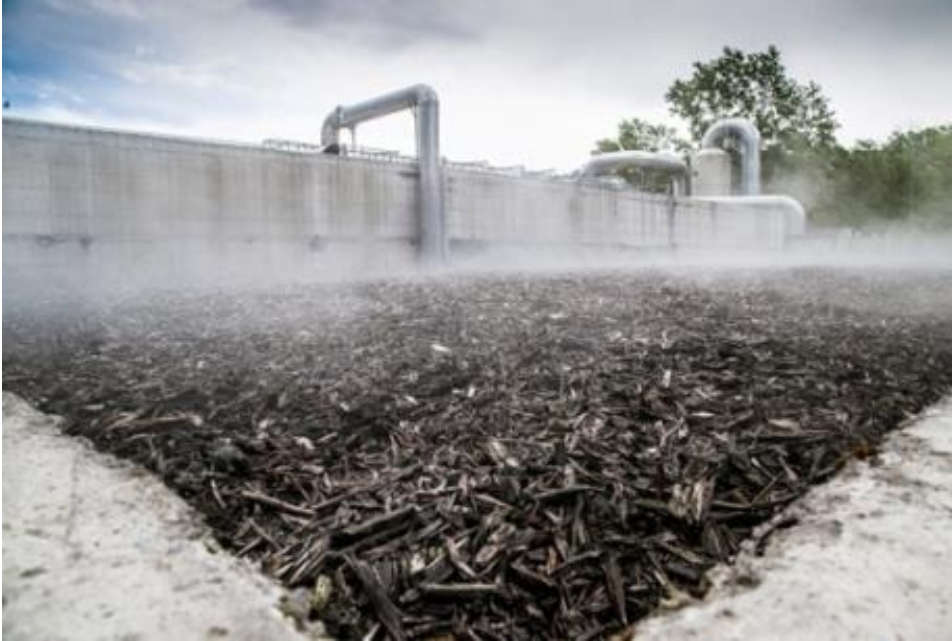
Figura 48 Biofiltro
