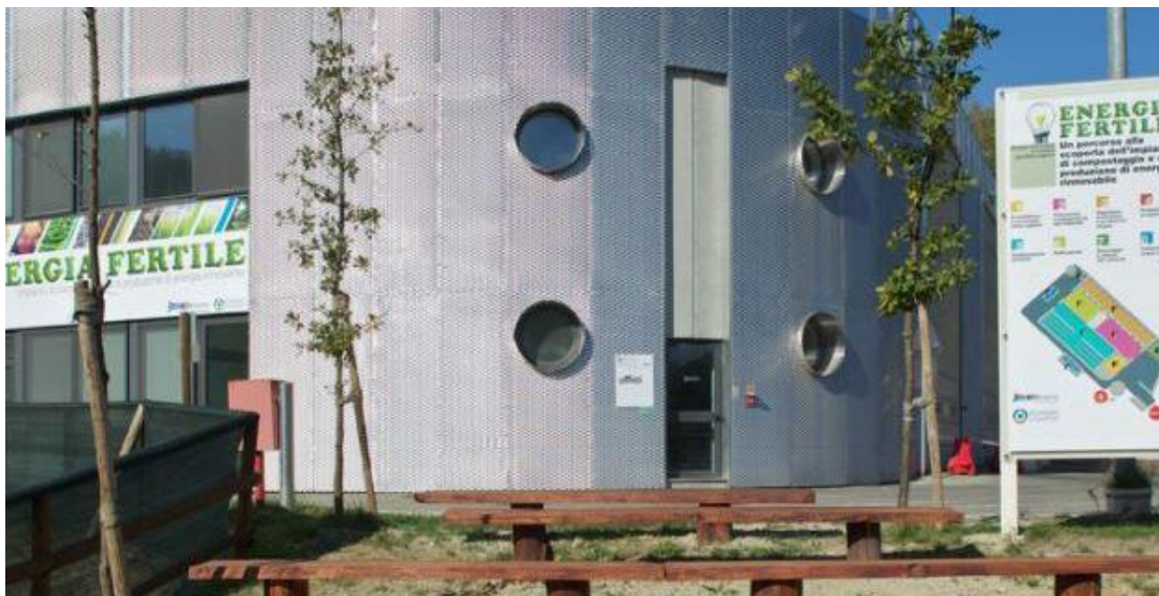
Figura 1 Particolare dell'impianto di compostaggio
