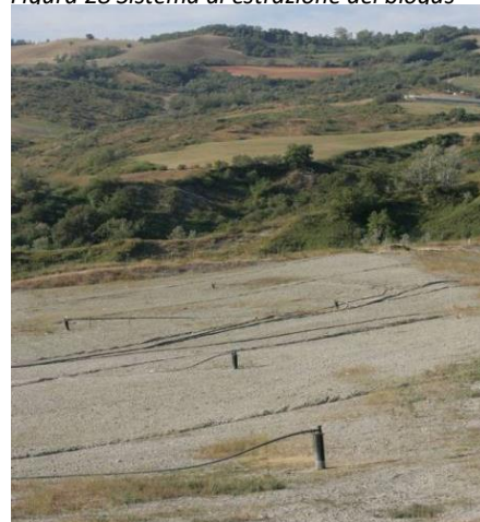
Figura 28 Sistema di estrazione del bioaas
