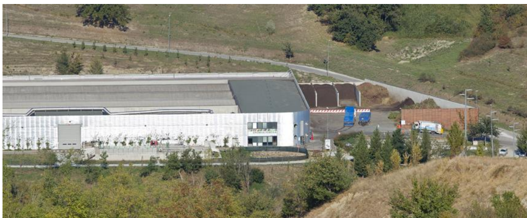
Figura 8 Vista dell'impianto di compostaggio
