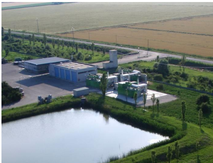
Figura 14 Impianto di produzione di energia elettrica
