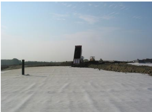
Figura 7 Operazioni di copertura definitiva
