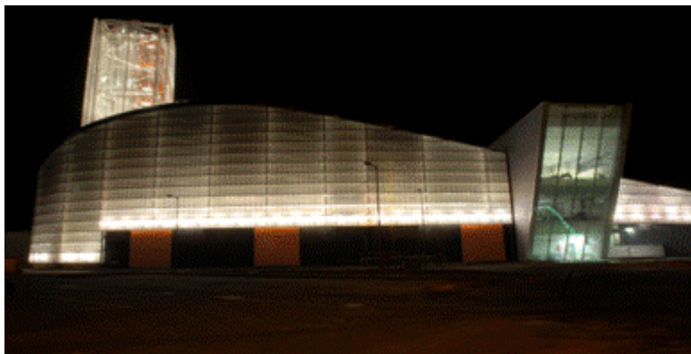
Imola 80 MW CCGT Cogen. plant
